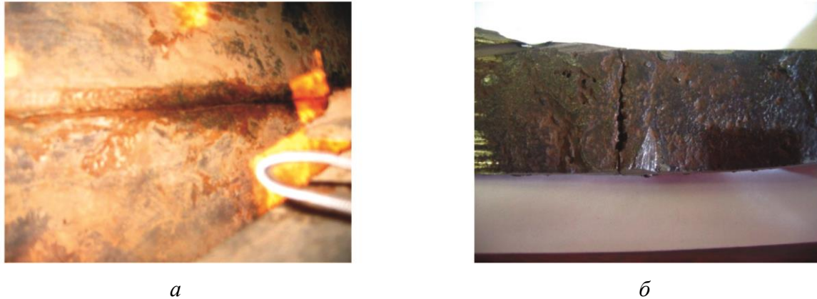
Рис. 2. Трещины в монтажном шве листов днища (а) и в перекрестиях швов днища (б)
